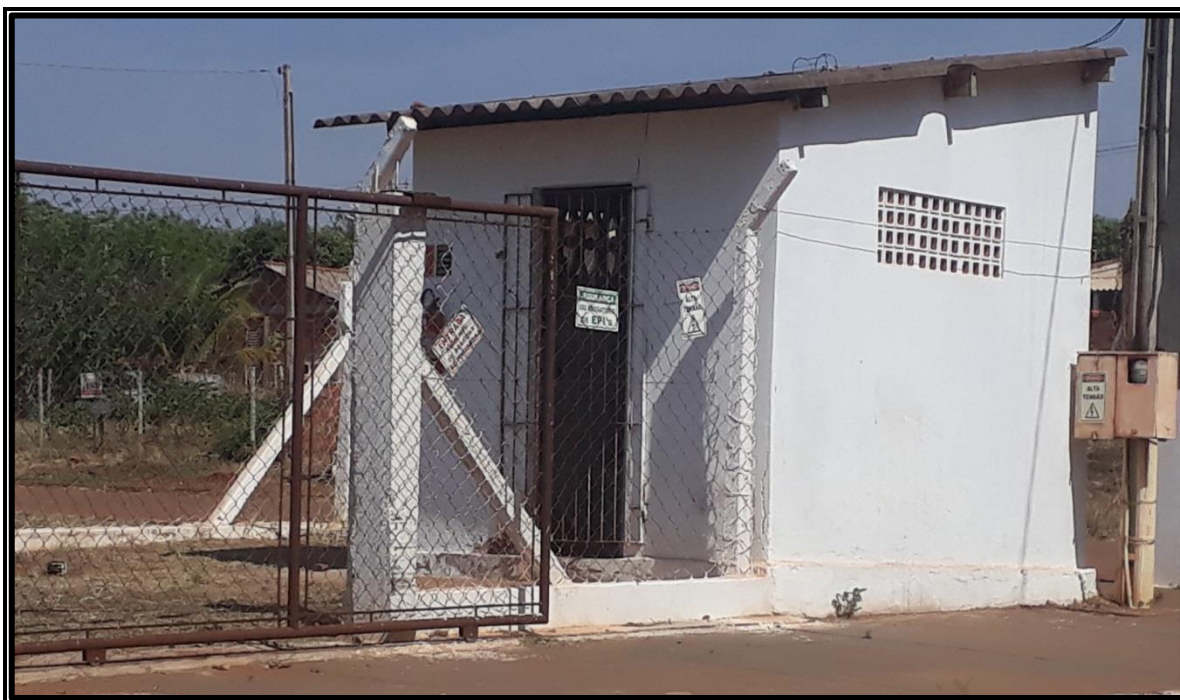
Foto 3- Local das bombas dosadoras.
