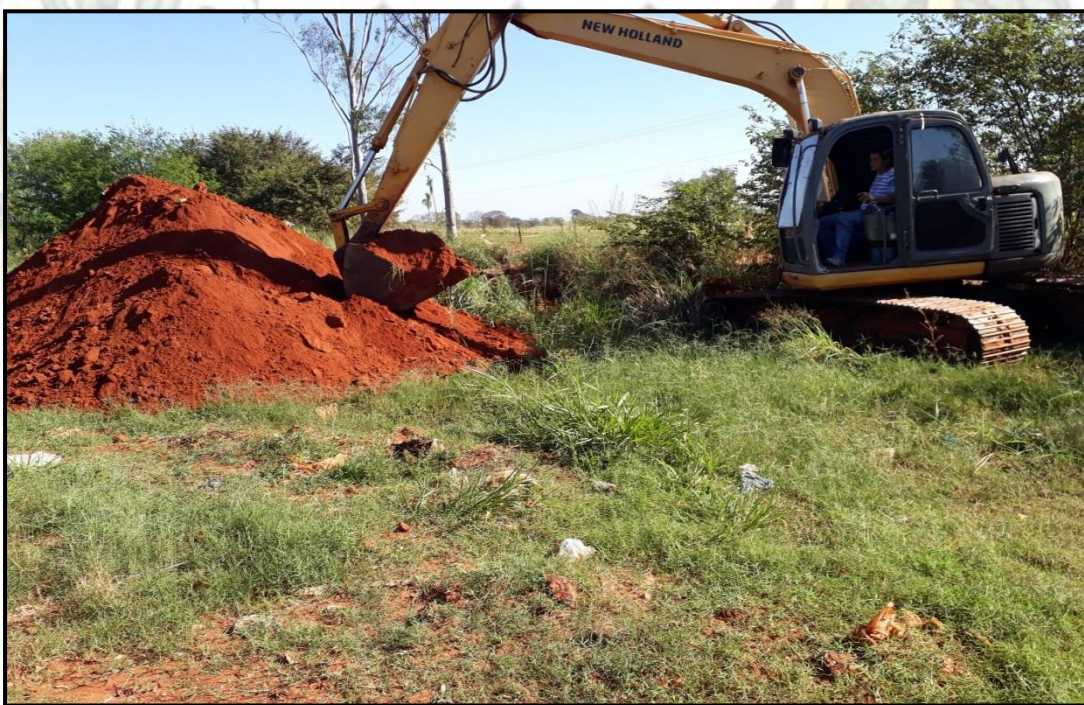
Fotos 3 - Vista de sistema de abertura das valas.
