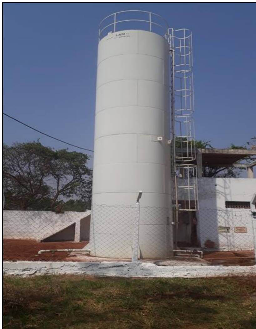
Foto 2- Local onde fica as bombas , edificação ao lado.
