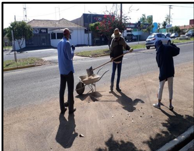
Fotos 1 , 2 e 3: Serviços de limpeza.
