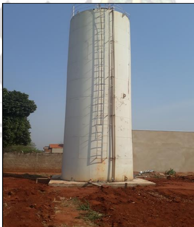
Foto 2 – Reservatório, localizado no Aquarius 2.
